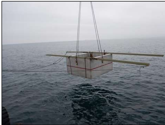
図 3-52 海底設置容器の敷設
