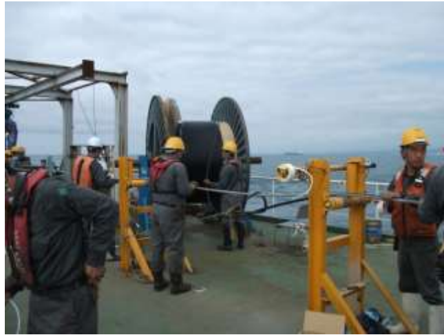
図 3-51 海底ケーブルの敷設
