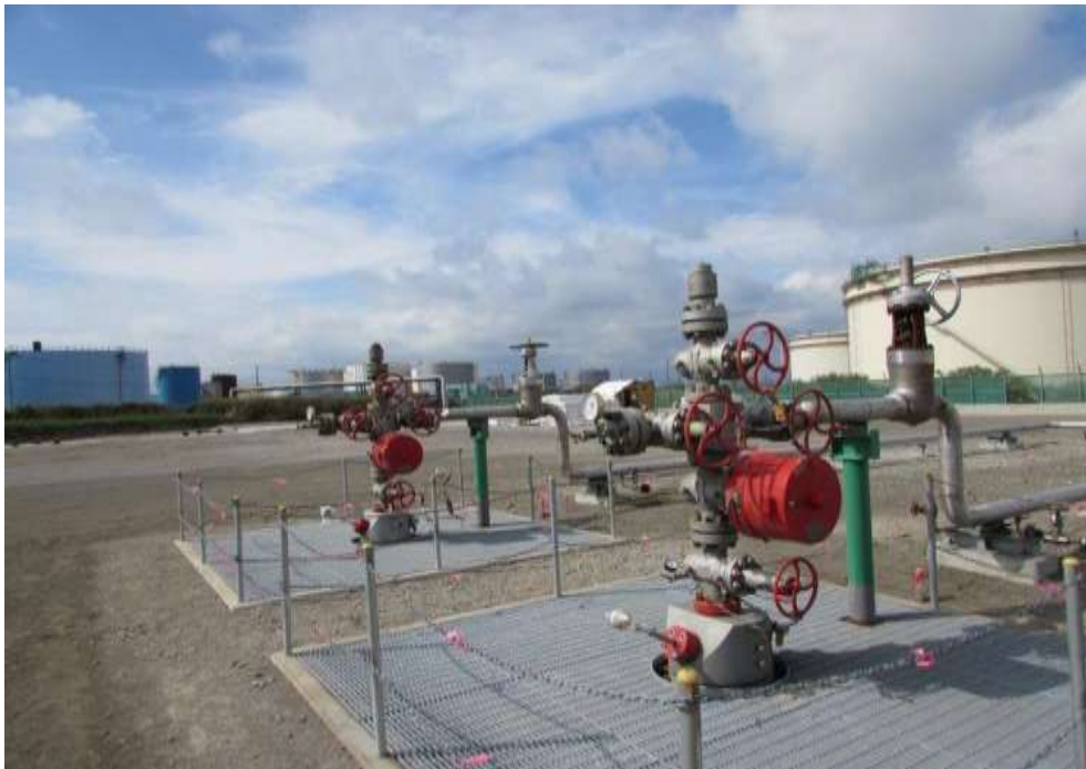
図 3-2 圧入井 2 坑の坑口装置
