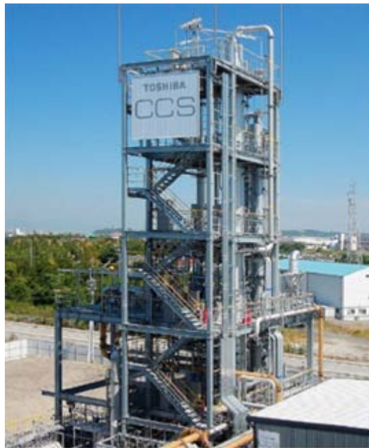
図 3-36 東芝のパイロットプラント試験設備
