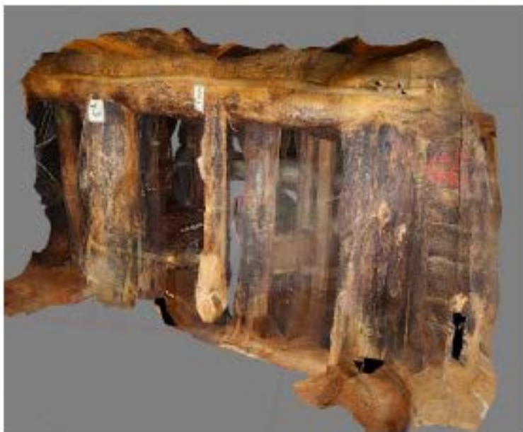
坑道形状の3次元測定の実例(立坑)
