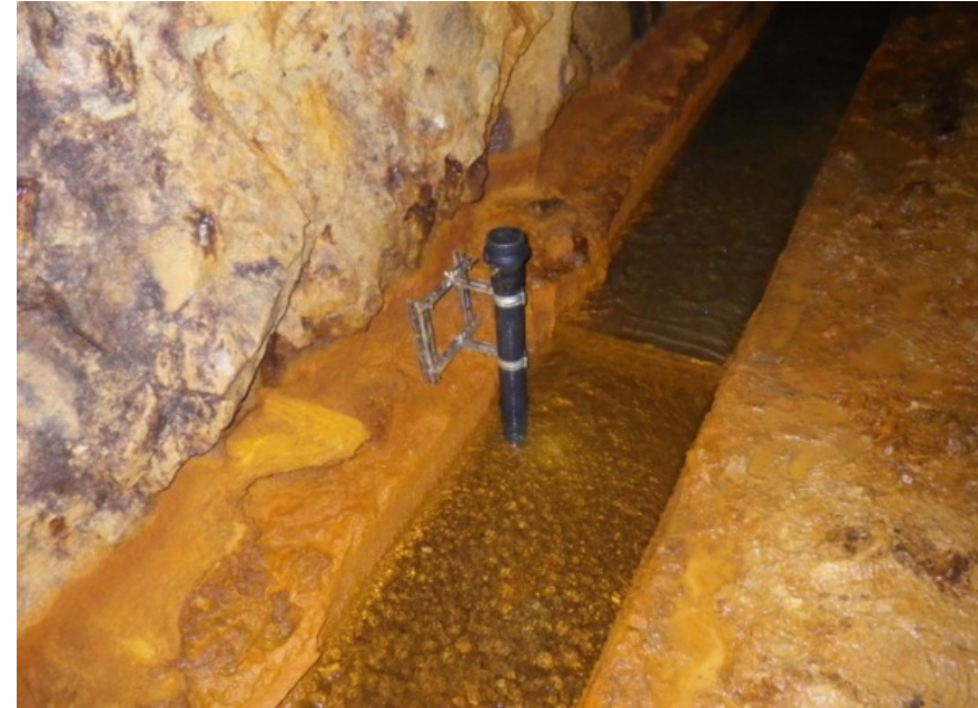
モニタリングの例 (坑内水量測定)
