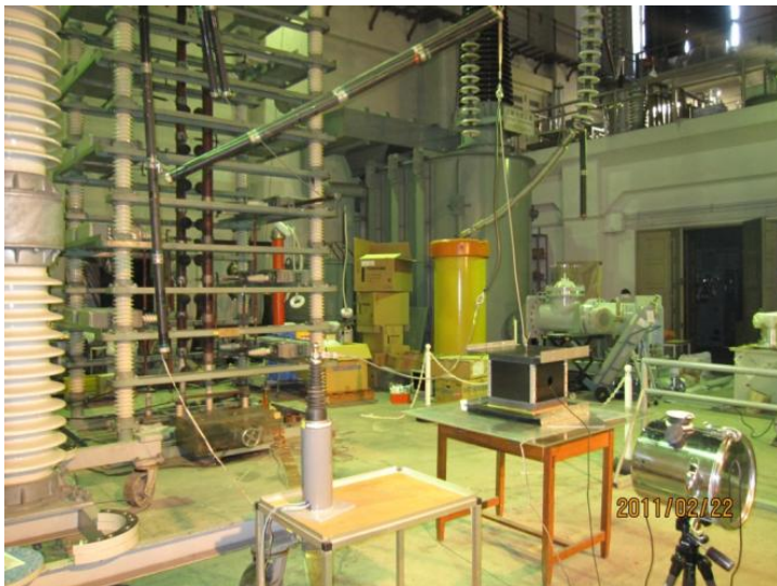
図3-5 雷インパルス試験状況写真 (東京大学)
