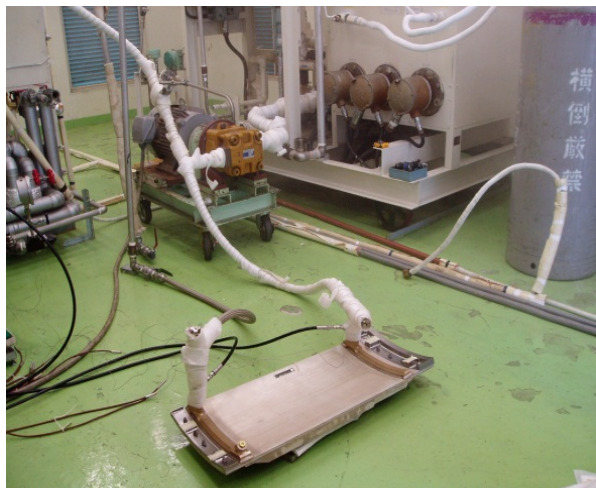
ASSC試作品潤滑油側圧力損失試験
