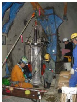
溶接部腐食試験装置の設置作業
