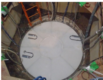
地下施設で実証中の地中無線装置
