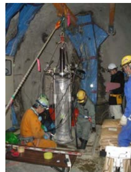
溶接部腐食試験装置の設置作業
