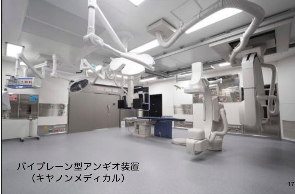
バイプレーン型アンギオ装置
