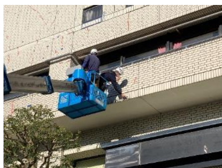
外壁打診調査
