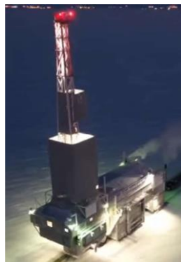
使用する掘削リグ
