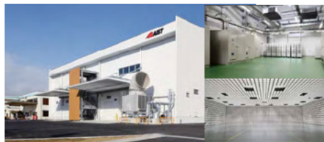
スマートシステム研究棟
