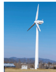
風力発電設備
