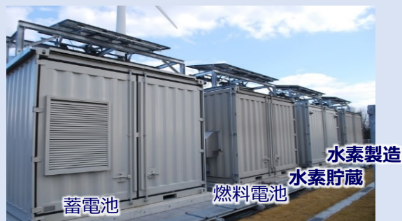
構築した水素エネルギーシステム実証設備
