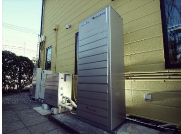
家庭用燃料電池 コージェネレーションシステム 「エネファーム」
