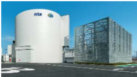
多目的大型実験棟・排煙処理設備 (燃烧・爆発試験、水害・津波 を想定した試験等を実施)
