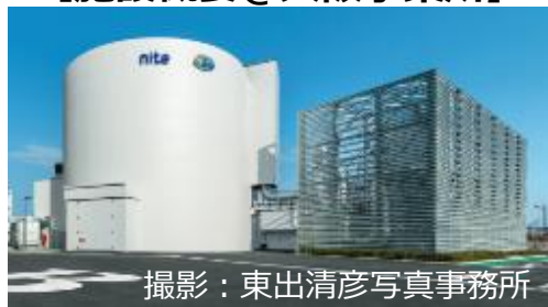
撮影：東出清彦写真事務所 多目的大型実験棟・排煙処理設備の外観
