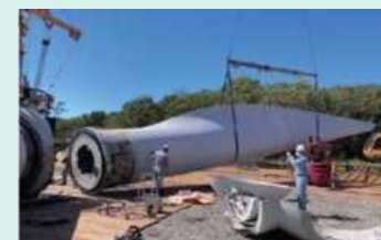
例：風力発電のブレードの解体
