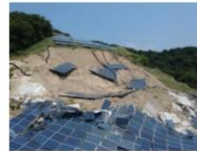
土砂崩れで生じた崩落
