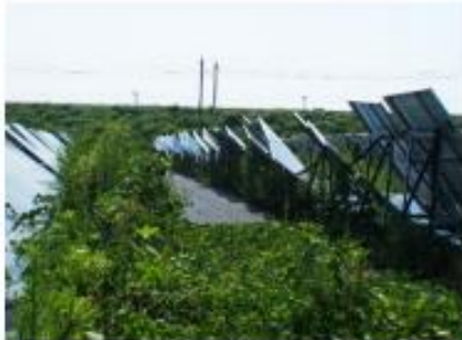
不十分な管理で放置されたパネル
