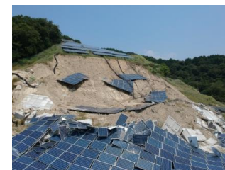
土砂崩れで生じた崩落
