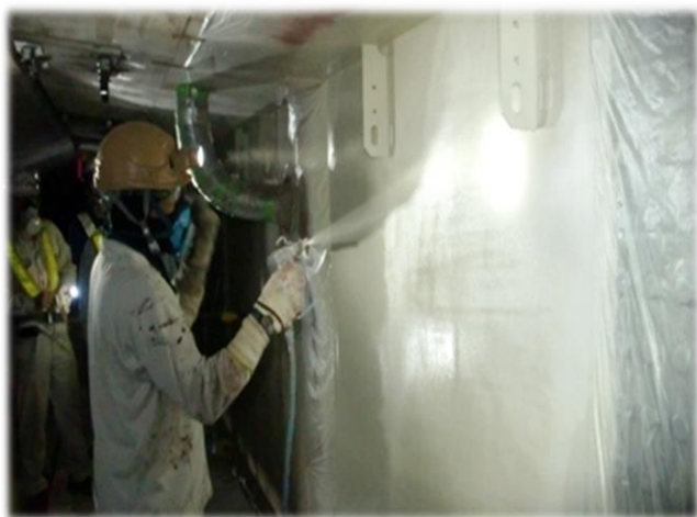
高速道路水性塗料塗替え工事の実績例 【首都高速道路(株)】
