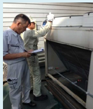
機器外観の検査
