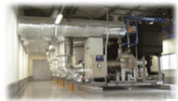
＜中央方式冷凍冷蔵機器＞
