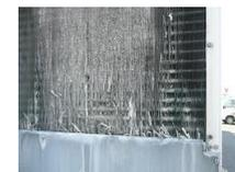
室外機の油にじみ 室外機の腐食
