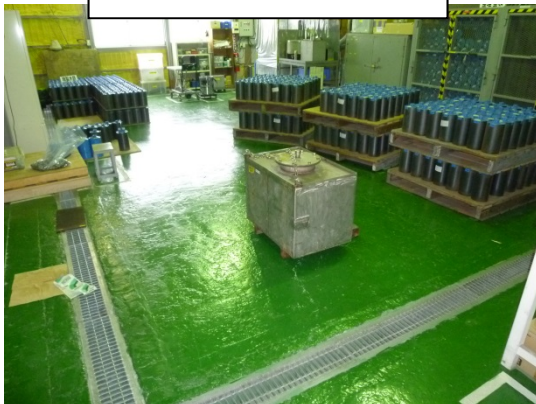
漏洩、地下浸透措置状況
