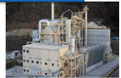
栃木工場バイオマス発電設備 (住友大阪セメント(株))
