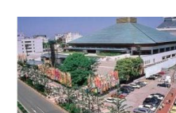
銅屋根(緑青銅板)
