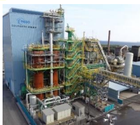
12m 3 小規模試験高炉(水素還元)
