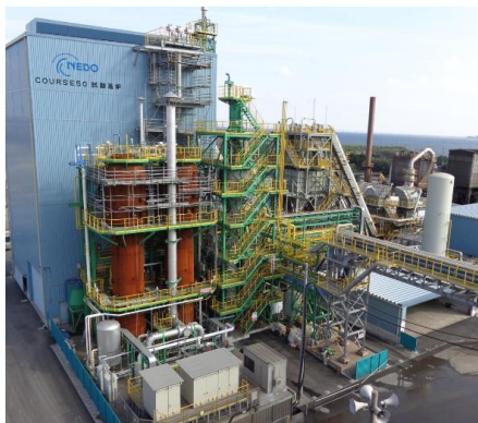
12m 3 小規模試験高炉(水素還元)
