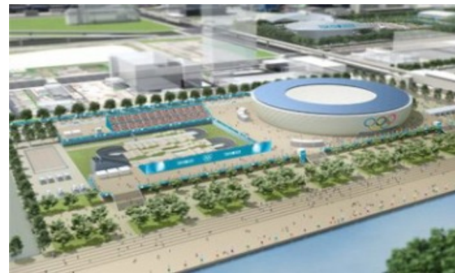
ベロドロームとBMXコース 江東区有明周辺に仮設
