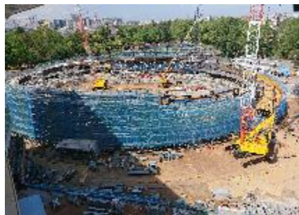
▲建設中の新千葉競輪場 2020年5月27日現在
