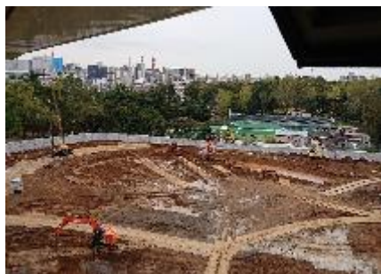
▲旧千葉競輪場が取り壊され更地となった状態
