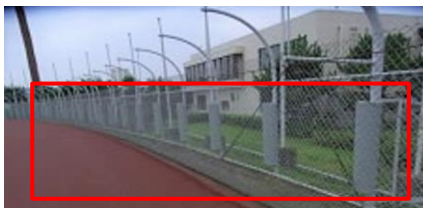
支柱緩衝材の全面設置
