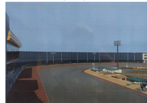
【川口オート 防音壁の設置】
