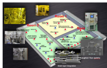
日本最大級の超電導回路専用クリーンルーム (QuFab)
