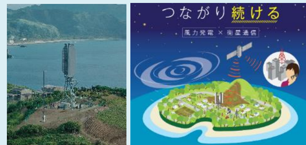
▲ 垂直軸型マグナス風力発電機 10kW実証機 (フィリピンバタン島)
