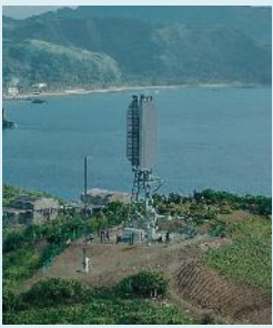
▲垂直軸型マグナス風力発電機 10kW実証機（フィリピンバタン島）
