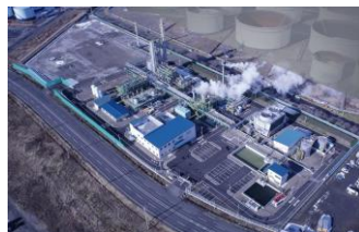
CO2分離・回収・貯留施設
