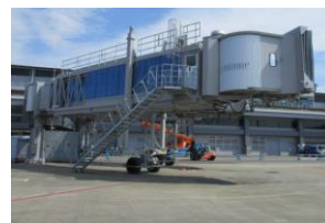
段差の解消（旅客搭乗橋）
