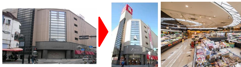
閉鎖した商業施設
