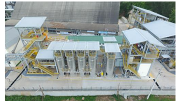
Cellulosic Biomass Technology Co. Ltd.、非可食糖製造技術実証プラント（タイ王国ウドンタニ県）
