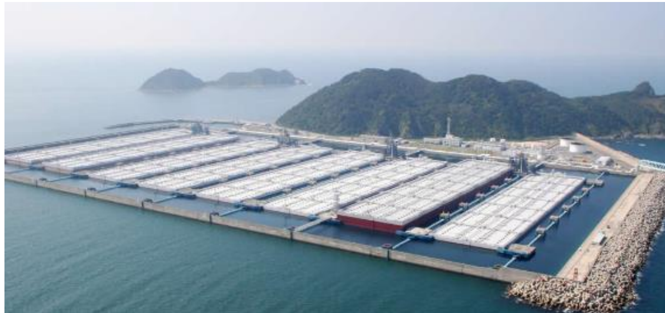
3/27(金)から国家備蓄原油の放出が開始された白島国家石油備蓄基地 出典：白島展示館HP ( https://museum.shirashima.jp/facility/ )
