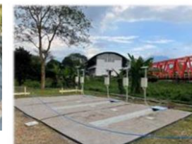
監視システム設置の様子
