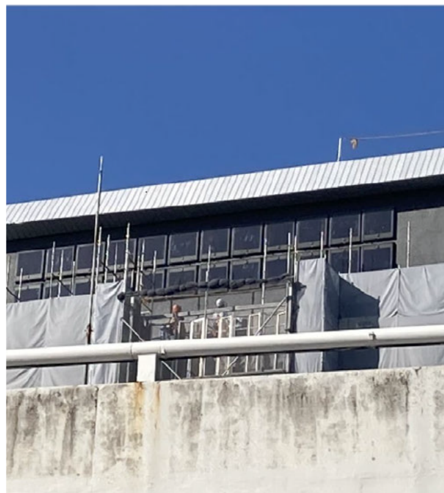
建物壁面への実装工事の様子
