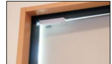
ドア上に設置した開閉センサーで
